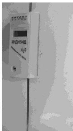
2. Совместить корпус прибора и тепловой адаптер.
